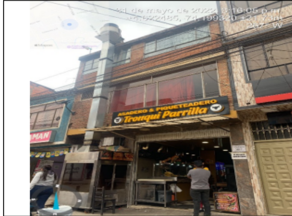
Fotografía No 1. Fachada del Predio.
